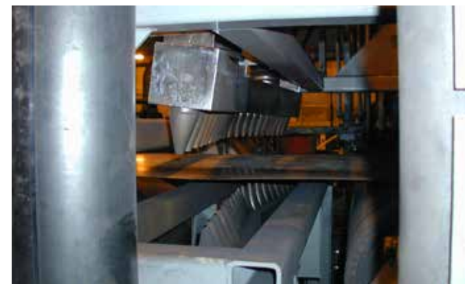
Bandstreckanlage V= 180 m/min.
