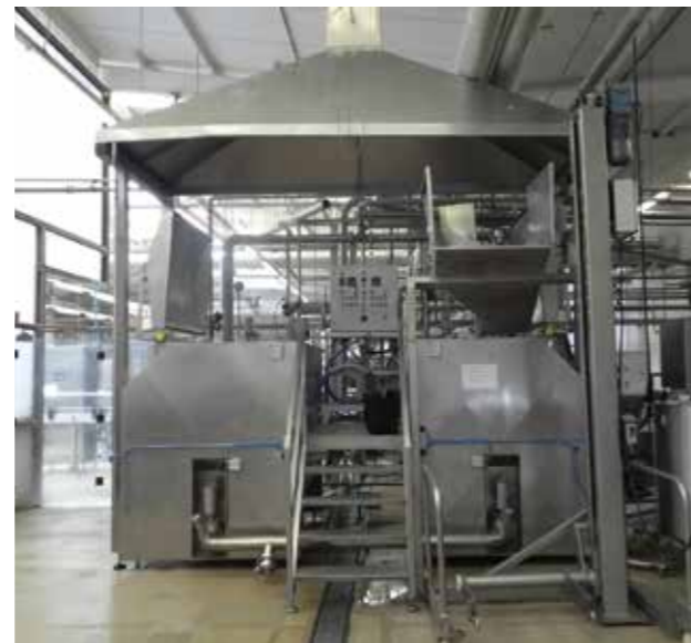
Installation einer Vorkoch - Anlage zur Herstellung von viskosen Produkten mit stückigen Bestandteilen, Inhalt: 1.500 Liter
