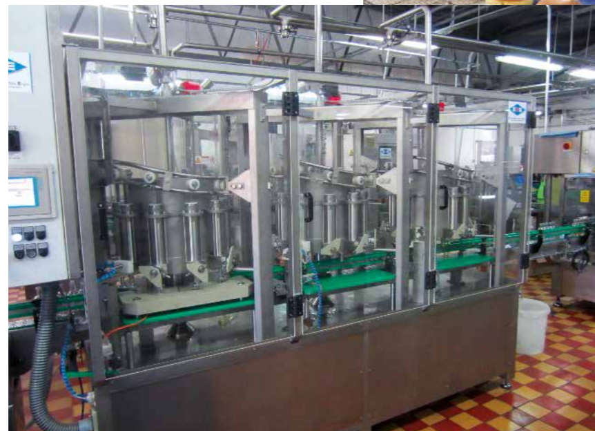
Installation von drei Kolbenfüllmaschinen innerhalb eines Maschinengehäuses
