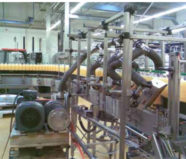
Beispiel einer Teststation beim Kunden
